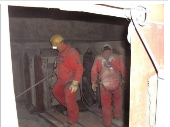
Voorbeeld: onvoldoende bescherming tegen blootstelling aan bodemas
